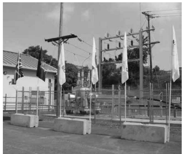
Fig. 22. Cable test site (Albany, NY)
