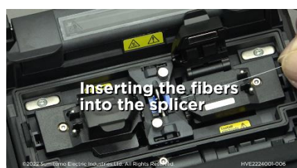
Colocar las fibras en la fusionadora
